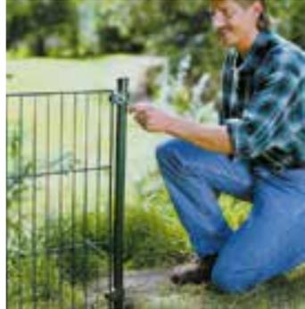
4. Monter les treillis de clôture
